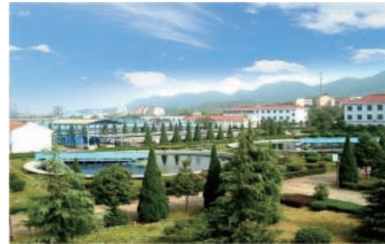
横店污水处理厂污水处理情况
